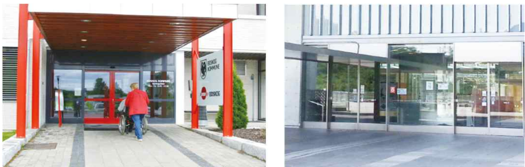
높이차이가 없고 누구나 인지 및 접근하기 쉬운 출입구, 자동문을 설치한 출입구
