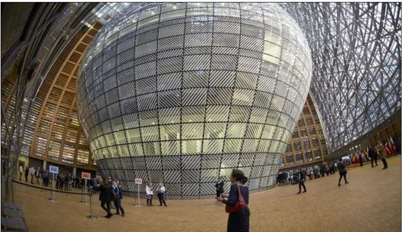
유로파 건물의 상징인 등불 모양의 업무 공간
