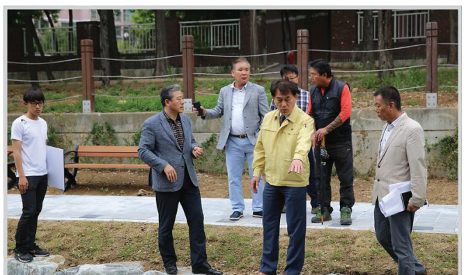
2017. 06. 09. 당하호 공원 내 시설물정비공사현장 방문
