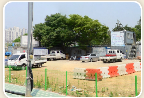
정서진중앙시장 주차장 현장사진
