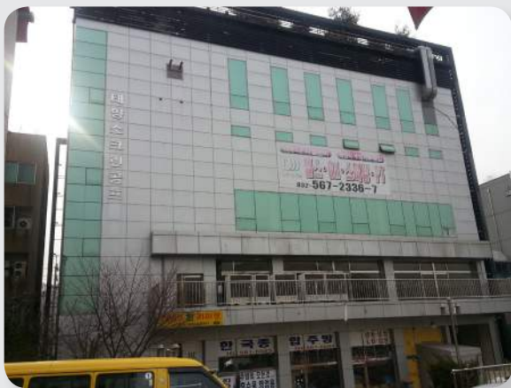
검단노인복지관 설치장소 (리모델링 예정)
