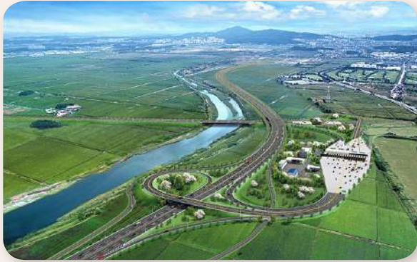
제2외곽 순환도로 건설사업
