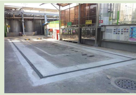
적재·하역장소 트렌치 설치
