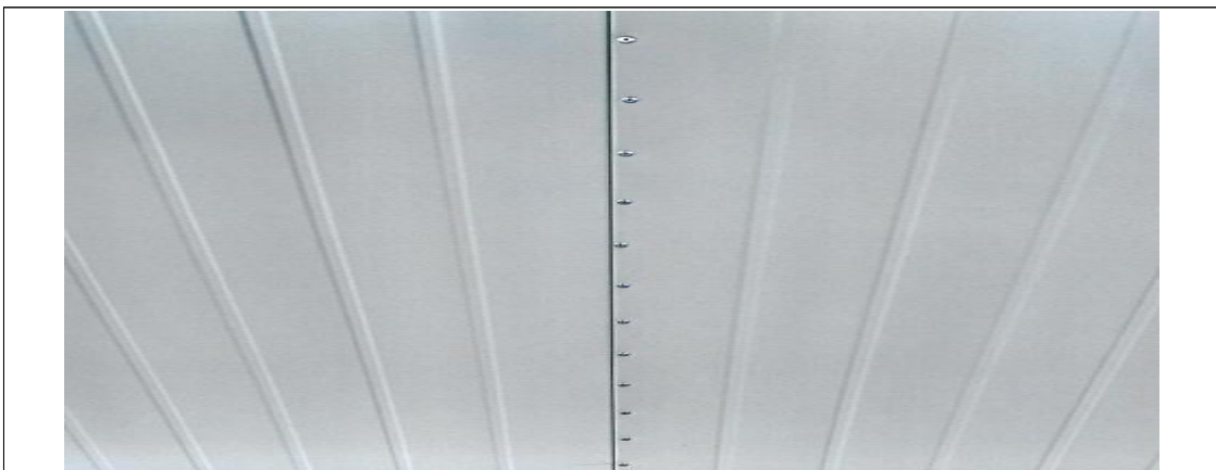
[그림 6-2] 샌드위치 패널 고정리벳(못) 마감 장면
