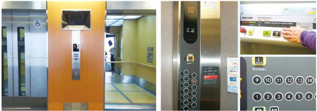
투시창 설치, 발로 누를 수 있는 엘리베이터 버튼, 후면 관찰용 전면 거울과 거울과 시청각 안내설치(좌), 조작하기 쉽고 인지하기 쉬운 양각형태의 조작버튼(우)
