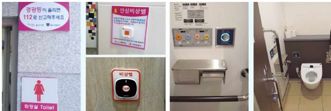
손이 닿기 쉬운 위치에 안심비상벨 설치(좌), 손이 쉽게 닿는 위치에 있는 알기 쉬운 세정버튼 및 각종 편의설치를 비치(우)
