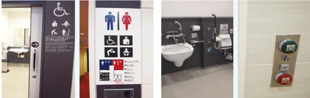
누구나 사용 가능한 다목적 화장실(좌), 이용자의 편의에 맞는 위생기구와 입출입 편의를 위한 잠금장치 겸용의 대형버튼(우)
