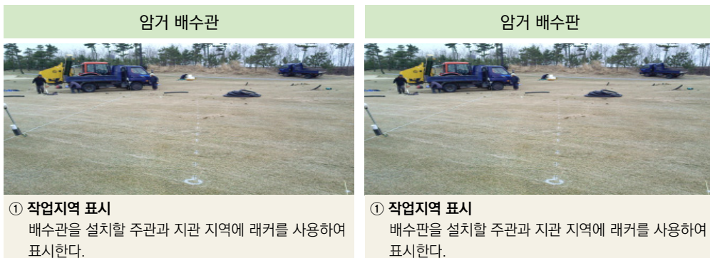
그림 20 '다' 골프장의 배수관 및 배수판 설치 과정
