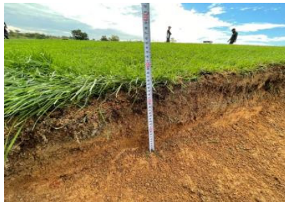
암거배수판 설치 지역 표토제거
