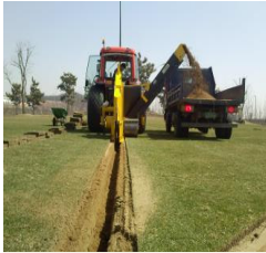
② 잔디 굴취 및 터파기 소드컷터로 폭 30cm, 두께 3cm로 잔디를 굴취한 다음 굴삭기를 이용하여 배수관 30cm 깊이로 터파기를 한다.
