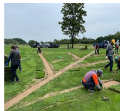
⑤ 잔디 식재 및 평탄화 정리된 면 위에 잔디를 식재하고 틈이 보이지 않도록 배토하고 관수를 통해 주변을 깨끗이 정리한다.
