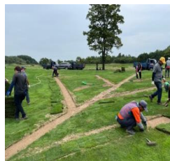
⑤ 잔디 식재 및 평탄화 정리된 면 위에 잔디를 식재하고 틈이 보이지 않도록 배토하고 관수를 통해 주변을 깨끗이 정리한다.
