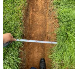
② 잔디 굴취 및 터파기 소드컷터로 폭 30cm, 두께 3cm로 잔디를 굴취한 다음 굴삭기를 이용하여 배수판 20cm 깊이로 터파기를 한다.
