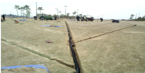
③ 배수관 설치 배수관으로 토양이 유입되지 않도록 터파기한 바닥에 부직포를 깔아주고 그 위에 배수관을 설치하여 한랭사로 감싸준다.
