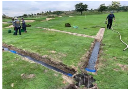
암거배수판 설치 후 토양 포설
