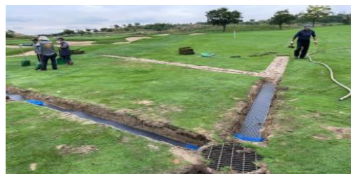
③ 배수판 설치 터파기한 주관과 지관에 배수판을 설치하고 지관은 주관 밑으로 넣어 고정하고, 끝부분은 한랭사로 감싸준다.
