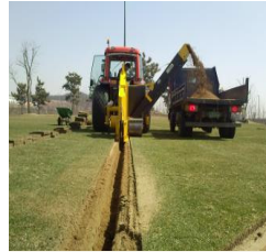
② 잔디 굴취 및 터파기 소드컷터로 폭 30cm, 두께 3cm로 잔디를 굴취한 다음 굴삭기를 이용하여 배수판 20cm 깊이로 터파기를 한다.
