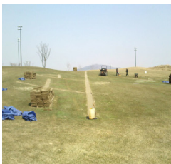
⑤ 잔디 식재 및 평탄화 정리된 면 위에 잔디를 식재하고 틈이 보이지 않도록 배토하고 관수를 통해 주변을 깨끗이 정리한다.
