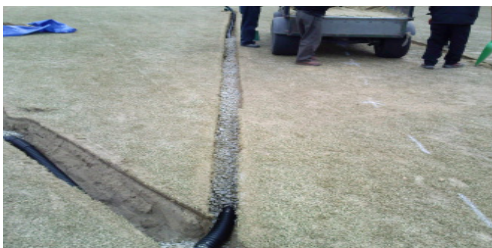
④ 자갈·모래 포설 및 다짐 배수관 위에 규격에 맞는 자갈을 10cm가량 포설한 다음 모래를 17cm 두께로 균일하게 포설한 후 다짐 작업을 하여 면을 정리한다
