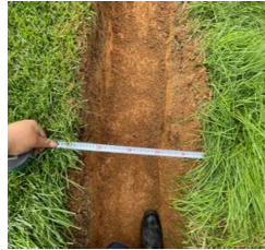
② 잔디 굴취 및 터파기 소드컷터로 폭 30cm, 두께 3cm로 잔디를 굴취한 다음 굴삭기를 이용하여 배수관 30cm 깊이로 터파기를 한다.
