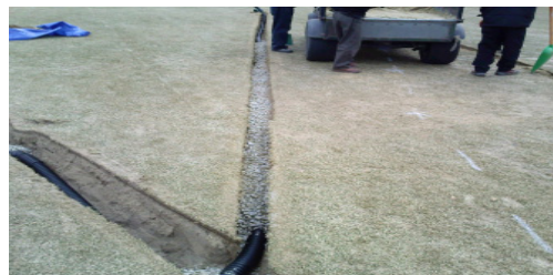
④ 자갈·모래 포설 및 다짐 배수판 위에 17cm 두께로 균일하게 모래를 포설한 다음 다짐 작업을 하여 면을 정리한다.
