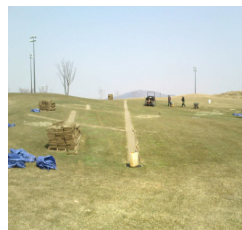
⑤ 잔디 식재 및 평탄화 정리된 면 위에 잔디를 식재하고 틈이 보이지 않도록 배토하고 관수를 통해 주변을 깨끗이 정리한다.
