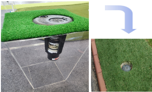
팝업형 관수시설 설치
