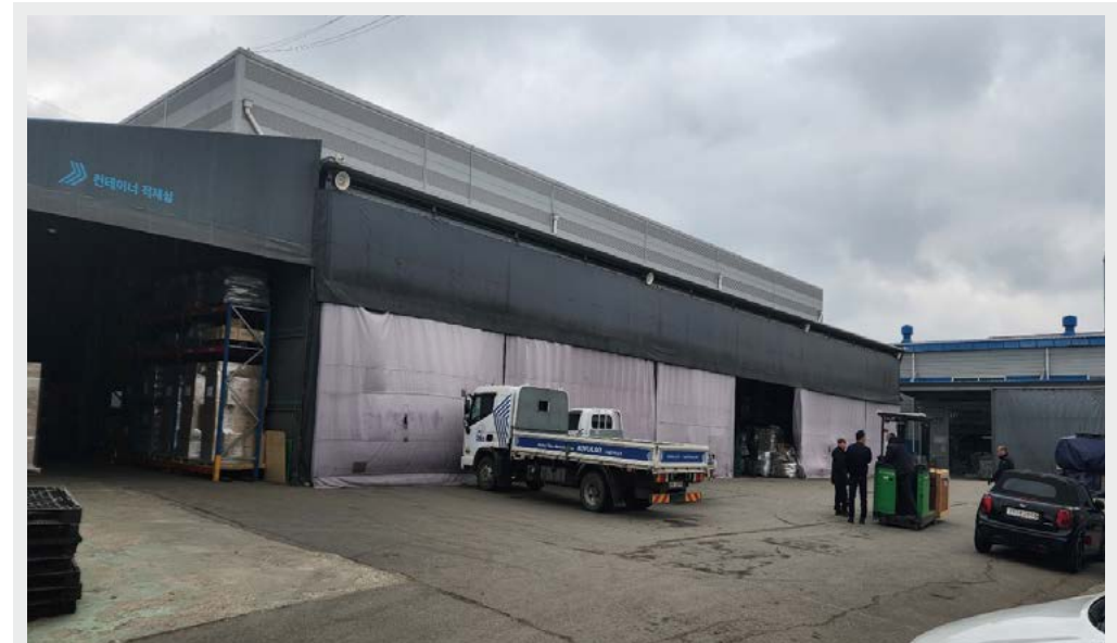
2024.10월 공장 건물 옥상 가설건축물 허가 현장
