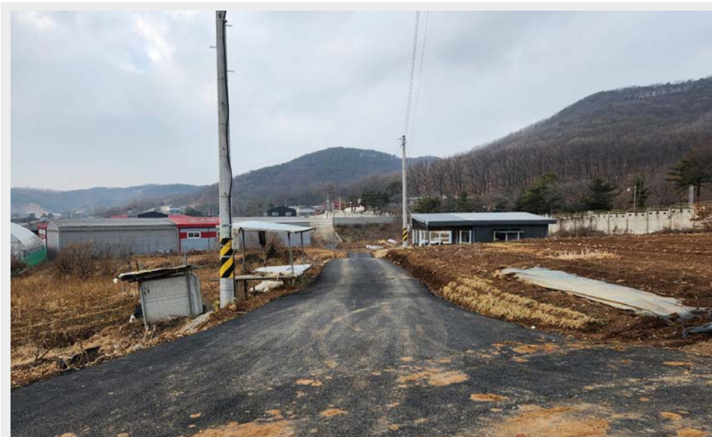
2024.1월 국유지 무단 아스콘 포장 현장
