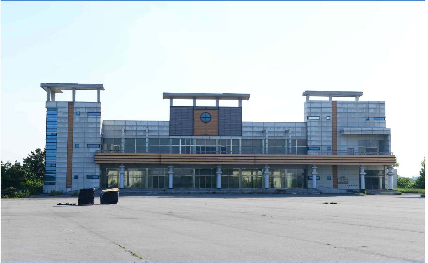
④ 건물 사진(근생 및 문화집회시설)
