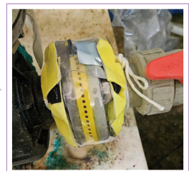
누출감지테이프 및 플랜지 커버 부착(예시)
