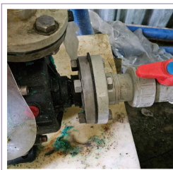
누출감지테이프 및 플랜지 커버 부착(예시)
