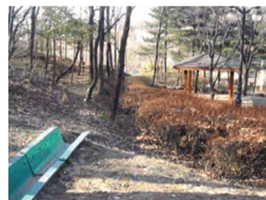
경사면 배수로 정비 요 → 배수로설치
